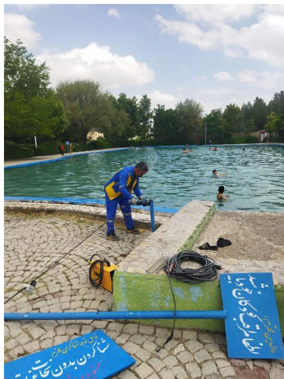
جوشکاری لوله ها و تابلو استخر بش قارداش
