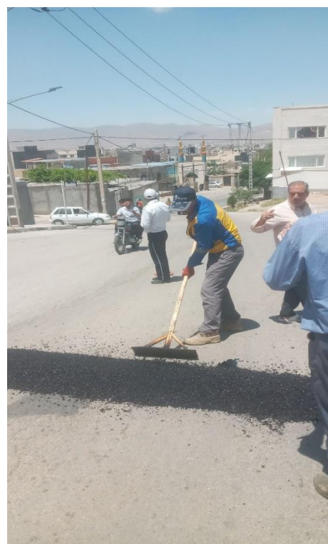
نصب سرعت گیر خیابان حر
