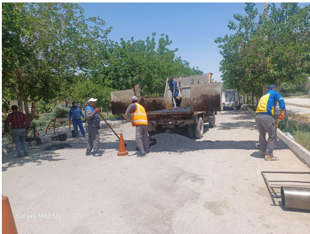
نصب سرعت گیر - خیابان پروین اعتصامی
