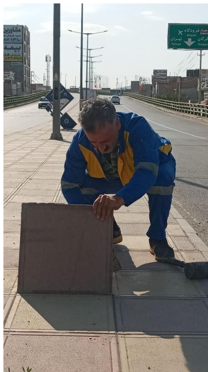
تعمیر موزائیک های پل ۱۹ مهر
