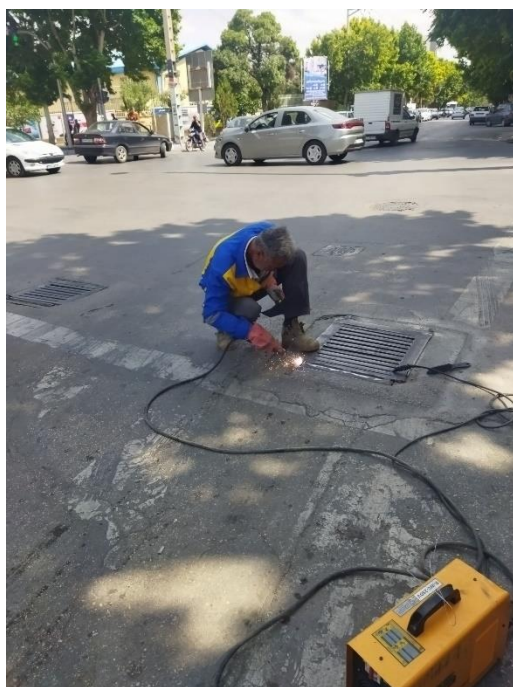
تعمیر دریچه آبهای سطحی چهارراه باسکول
