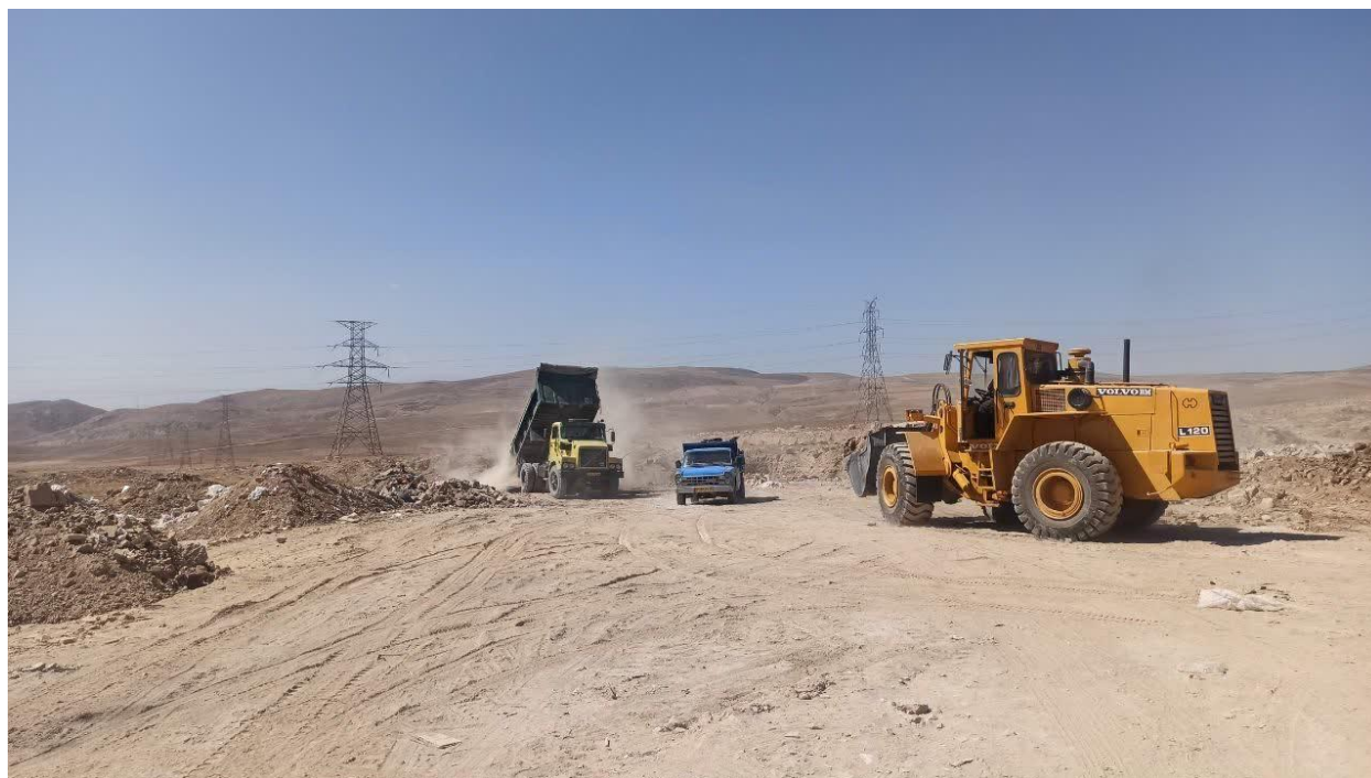
تسطیح محل دفن ضایعات و نخاله ساختمانی
