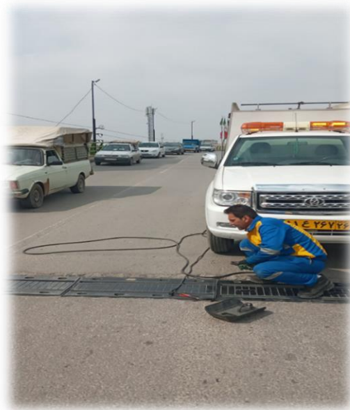
جوشکاری ضربه گیر پل ۱۹ مهر
