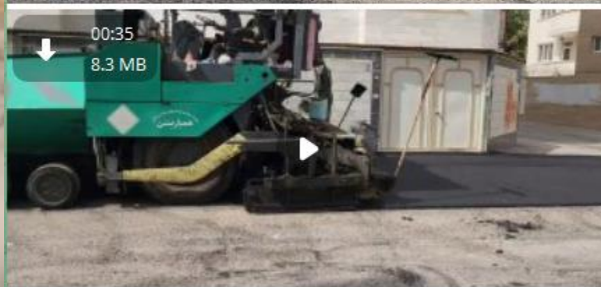
اجرای آسفالت در خیابان شهید صفا صفا ۳۲ 1:44 AM
