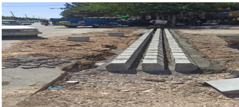
تک جدول بتنی پرسی ۳۰ بلوک ۱ و ۲ سطح منطقه ۲
