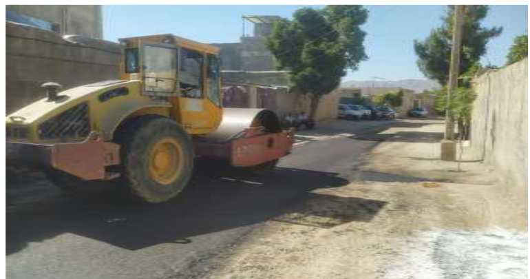
زیرسازی ولکه گیری آسفالت معابر سطح منطقه یک محله امام هادی (ع)
