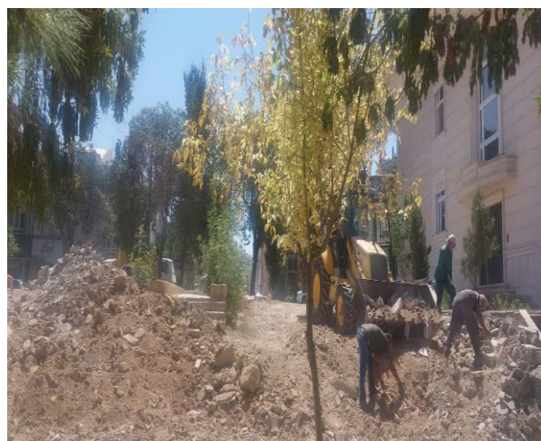
پروژه احداث و بهسازی فضای سبز پارک آذری
