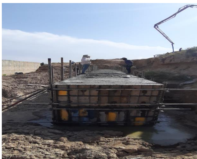
اجرای پایه ها و دیوارهای پل کشاورز
