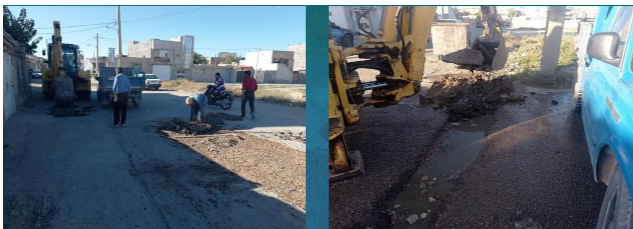
پروژه زیر سازی و آماده سازی جهت لکه گیری آسفالت
